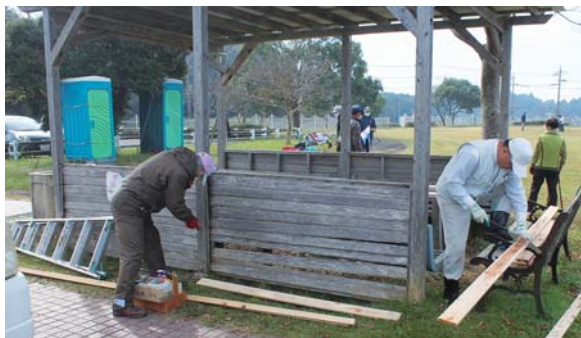
▲グラウンドゴルフ場内の休憩所を補修。傷んだ外板を張り替えた。
